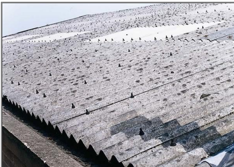
Rysunek 1. Dach pokryty azbestową płytą falistą
