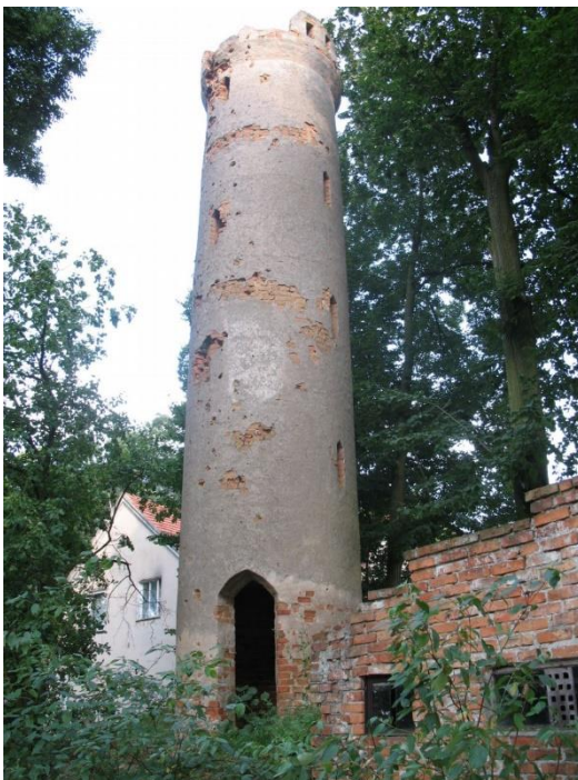
Fotografia 4. Tajemnicza wieża w Gąsiorkach
