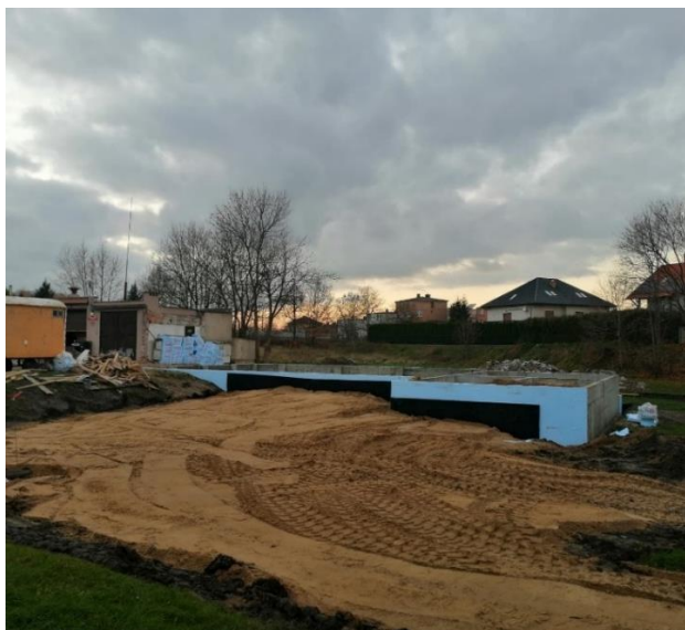
Prace ziemne na terenie budowy nowej Remizy. Morzeszczyn, Listopad 2021r.
