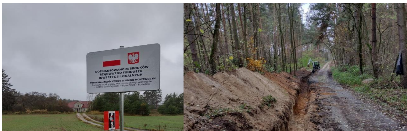
Fot. Budowa wodociągu Gąsiorki – Lipia Góra – Barłożno
