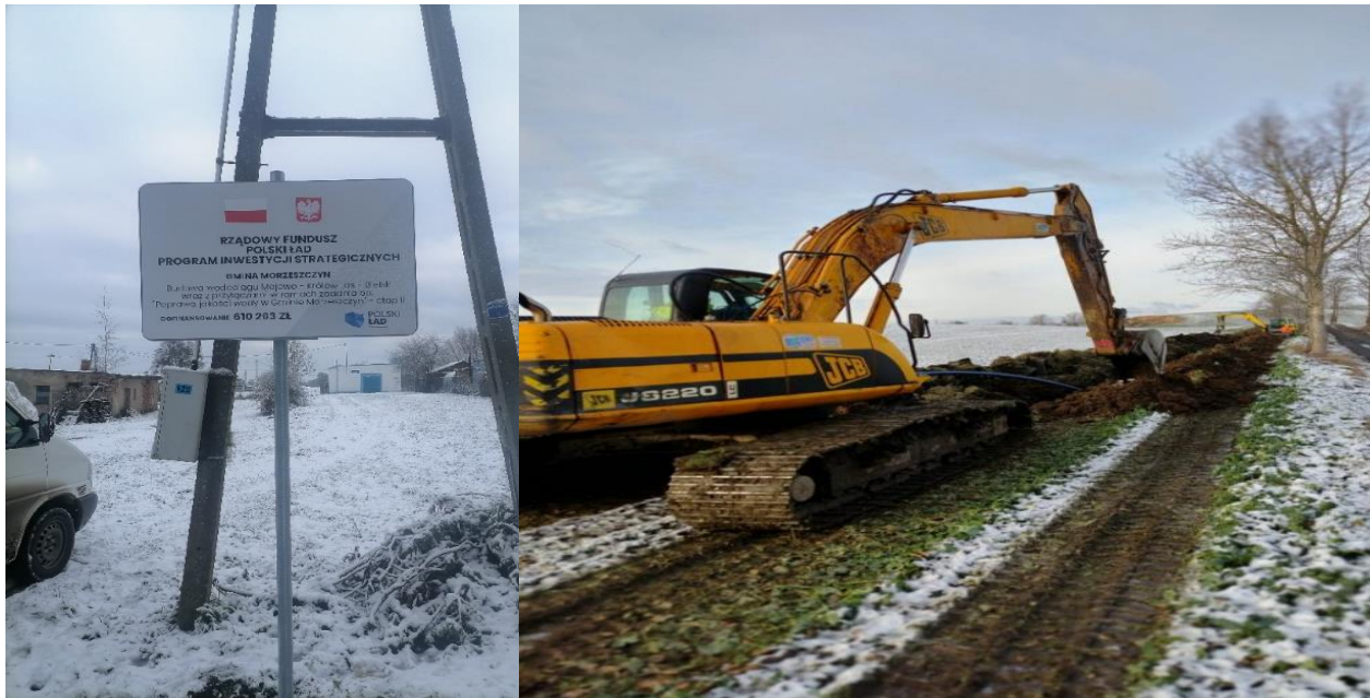
Fot. Budowa wodociągu Majewo – Królów Las – Bielsk
