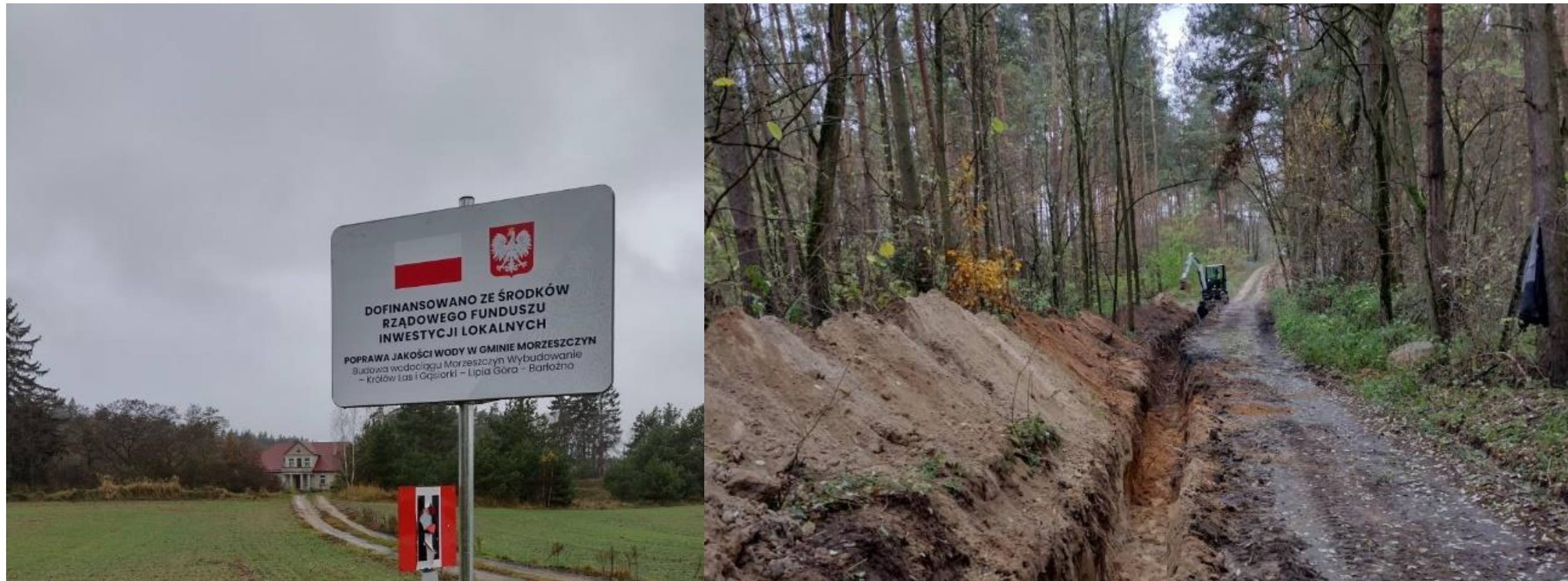
Fot. Budowa wodociągu Gąsiorki – Lipia Góra – Barłożno
